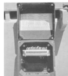
Slika 9 Priključna kutija termometara namotaja i ležaja
